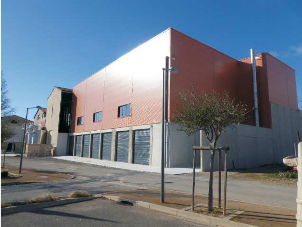
Côté Nord Est : nouveau local
