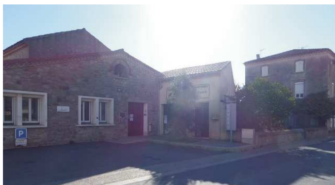
Bureaux et caveau de vente
