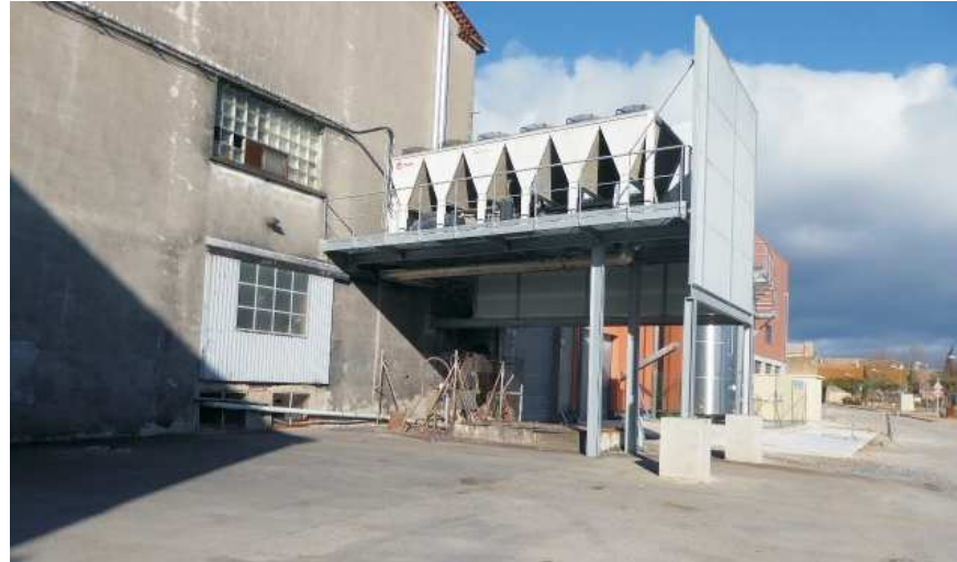
Côté Est : groupe de froid avec écran anti-bruit
