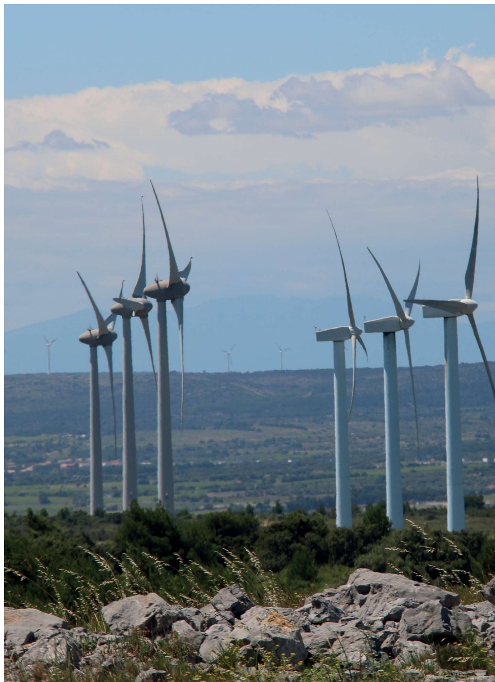
Les alignements parallèles aux gabarits hétérogènes des parcs éoliens de Corbières Maritimes et de l'Olivier
