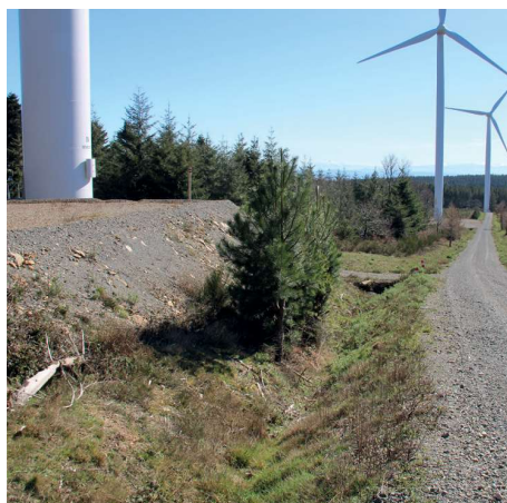
Les remblais comme les décaissements sont à éviter.
