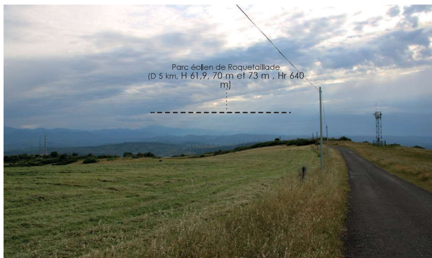
16- Depuis le futur site d'implantation du parc éolien de Saint-Polycarpe, les éoliennes de Roquetaillade sont en vis-à-vis dans un paysage aux vues perçantes
