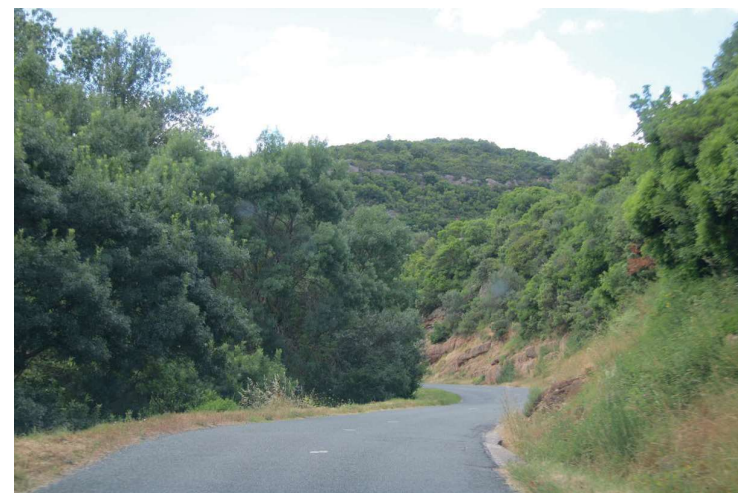
12- Depuis la D212, la route au cœur des Corbières suit les plissements du relief, le parcours est lent et enfermé dans la forêt
