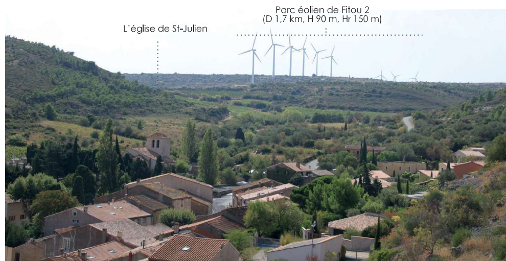
11- Depuis le village de Fitou, l'église de St-Julien comme les habitations sont visuellement très affectées par la proximité des éoliennes de Fitou 2
