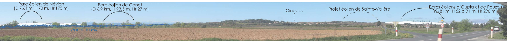
26 Depuis la D607 au niveau de la halte du Somail aux abords du canal du Midi, les parcs éoliens de Néviau, Canet et Oupia forment des rebonds visuels sur la ligne d'horizon. Le futur parc éolien de Sainte-Valière viendrait densifier la perspective
