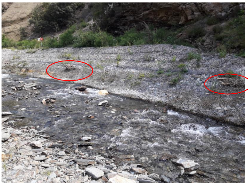
Illustration 4 – Vues de la protection en pied de la verse de Nartau et identification de laisses de crue
