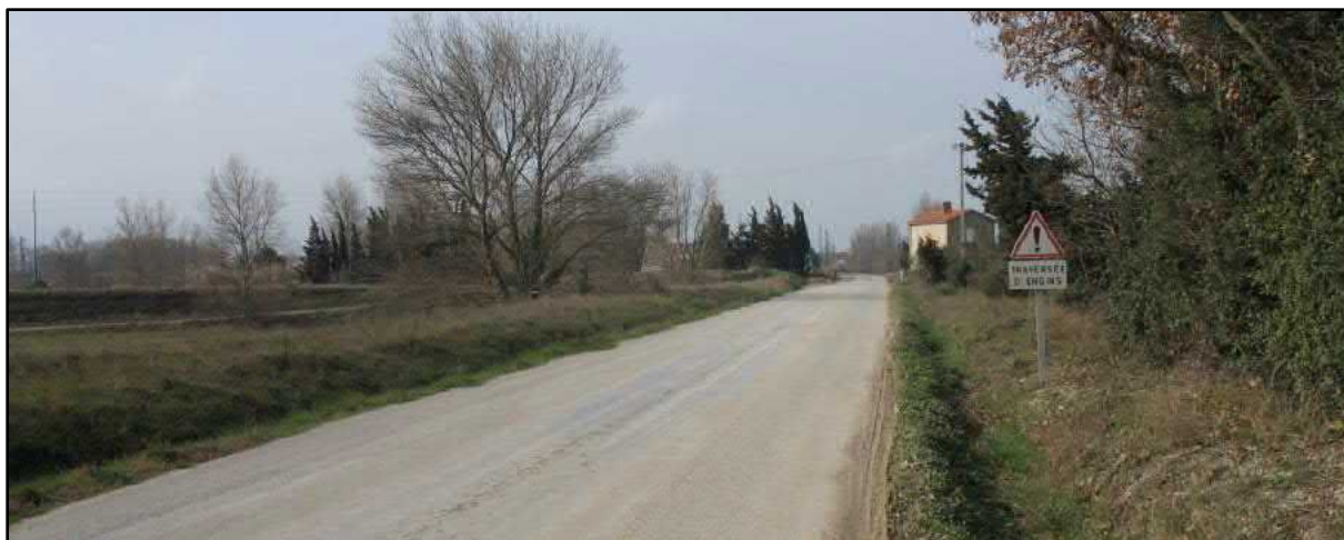
Figure 34: La RD 43 au droit du site, vue en direction de Bram
