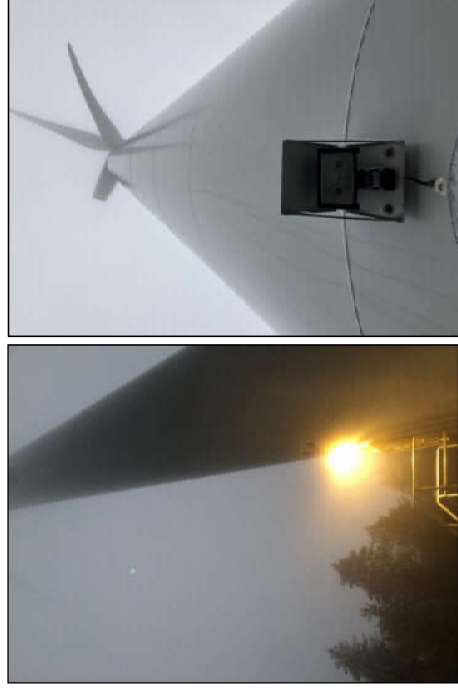
Figure 73 : Clichés pris le 20 décembre 2017 lors du contrôle de la sensibilité des spots lumineux présents au-dessus des portes de service (à gauche, spot lumineux allumé, à droite, spot lumineux éteint)
