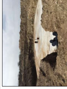
Excavation et béton de propreté Source : Artifex 2018
