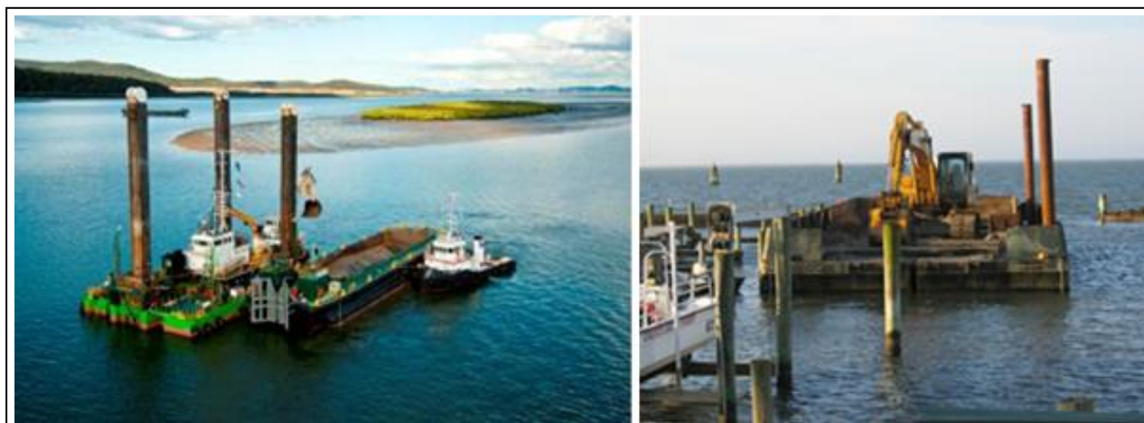
Figure 13 : A gauche : pelle rétro-caveuse, ici avec navire sablier et remorqueur ; à droite : pelle mécanique sur barge
