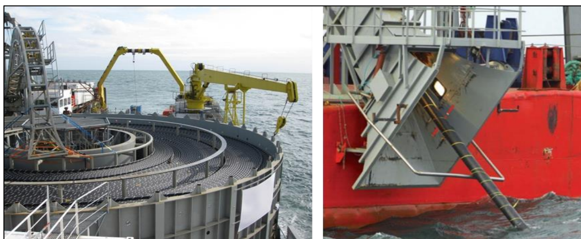
Figure 9 : Pose des câbles sous-marins
