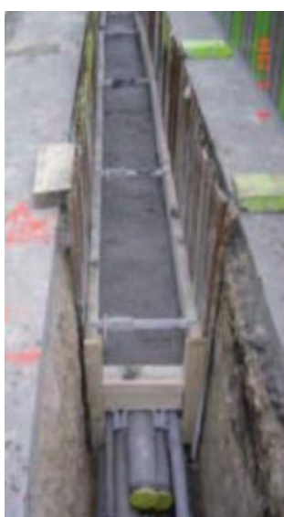
Pose en bord de chaussée
