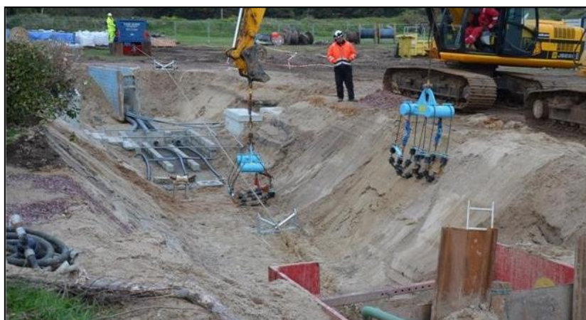
Figure 22 : Tirage au niveau de la chambre d'atterrage
