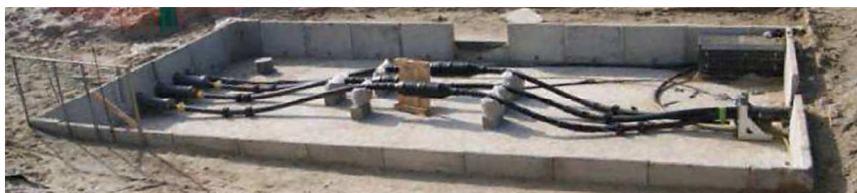
Figure 21 : Chambre de jonction d'atterrage en travaux
