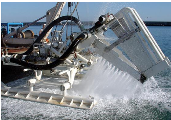
Exemple de jetting
