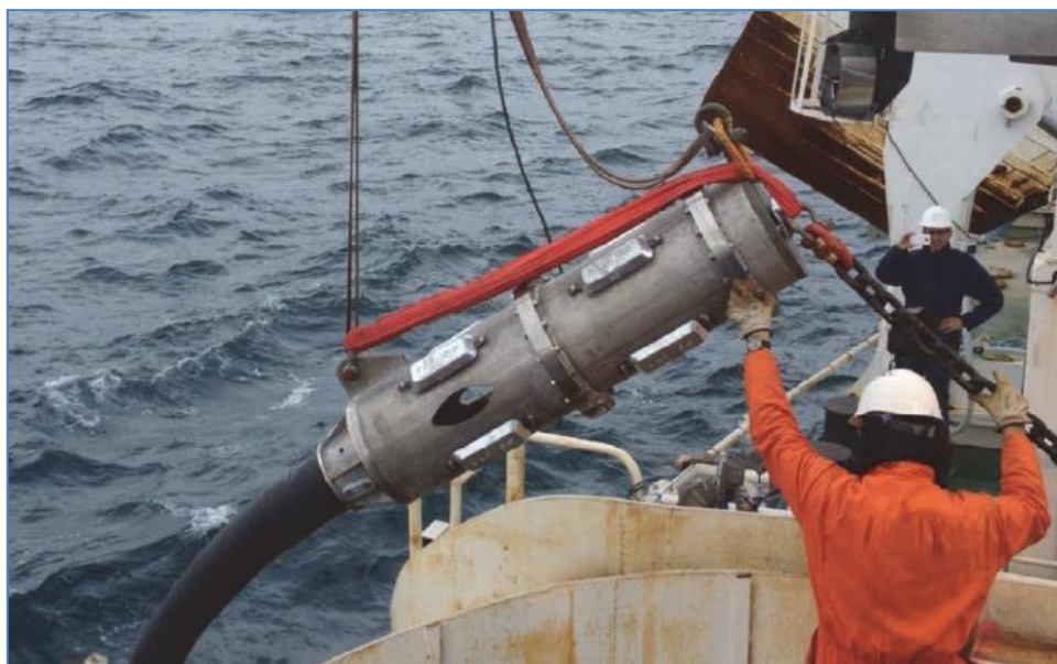
Figure 5 : Exemple de jonction sous-marine type « dry-mate »
