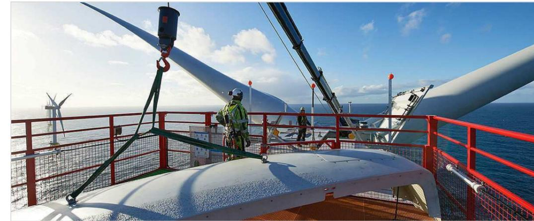
Figure 41 : Plateforme d'hélitreuillage d'une éolienne MV10 – 164 MVOW
