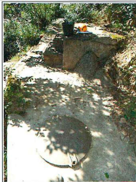
Regard de « répartition » entre Bugarach et Rennes-les-Bains = piquage sur l'adduction principale en direction de Rennes-les-Bains
