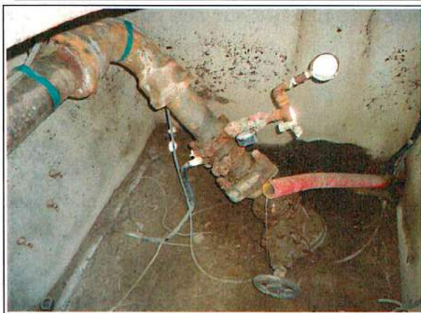
Regard de « répartition » entre Bugarach et Rennes-les-Bains = piquage sur l'adduction principale en direction de Rennes-les-Bains
