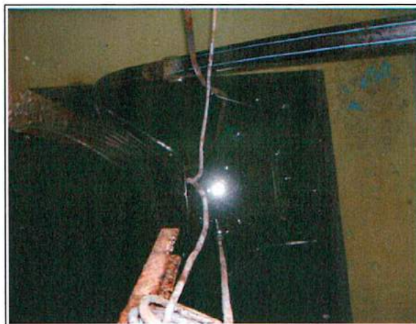
Bâche de reprise R2
