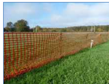
Filet orange de chantier
