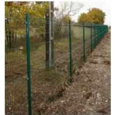
Figure 11 : Exemple de clôture souple simple torsion (Valeco)
