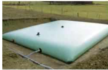
Figure 13 : Citene incendie (Valeco)
