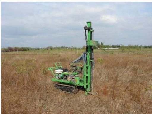
Sondage au pénétromètre
