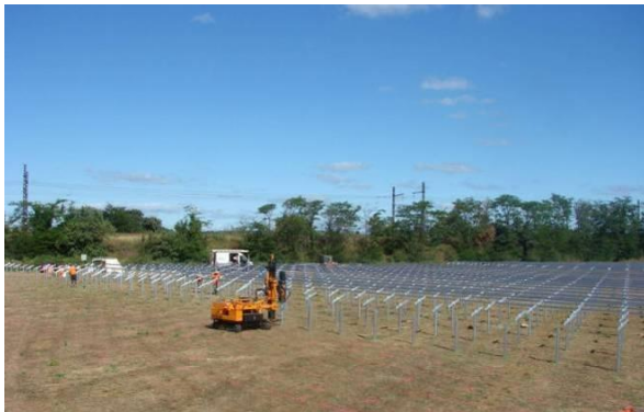
Battage des pieux
