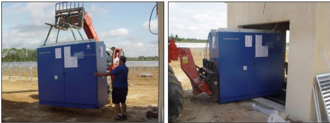
Installation d'un onduleur
