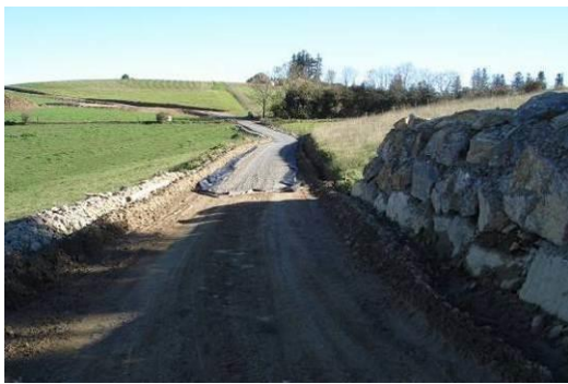
Mise en place du gravier
