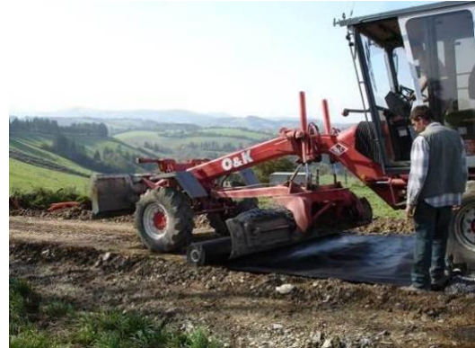
Pose du géotextile
