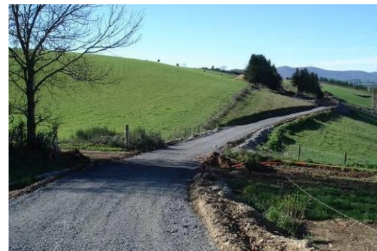
Mise en place du gravier
