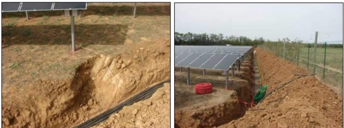
Tranchée drainant le courant continu
