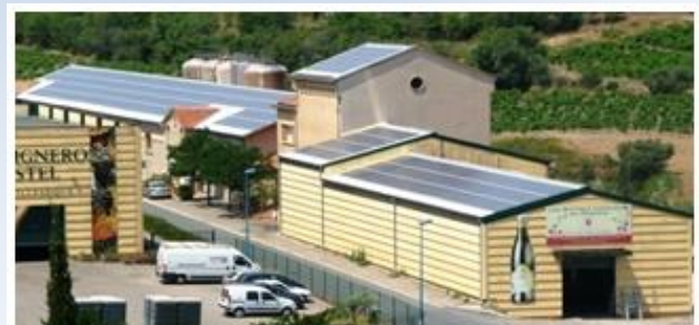
Cave Coopérative CASCASTEL (11) Puissance électrique : 99 kWc Mise en service : Juillet 2010
