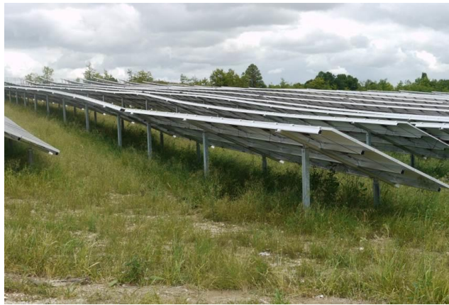
Revégétalisation, 1 mois après les travaux (centrale solaire du Sycala)
