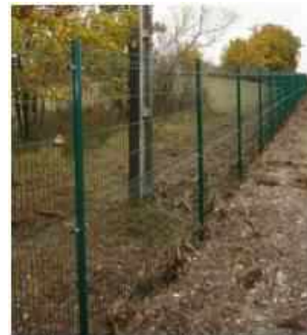
Figure 11 : Exemple de clôture souple simple torsion (Valeco)
