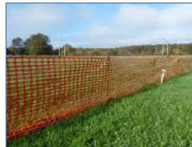
Filet orange de chantier
