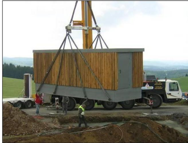
Exemple de livraison d'un poste de transformation électrique sur un parc éolien
