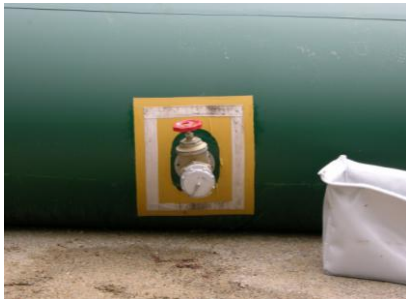
Prise directe de 100 mm sur une réserve d'eau souple
