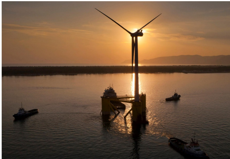
Photographie 6 : Remorquage du prototype WindFloat 1 (Source : PPI)
