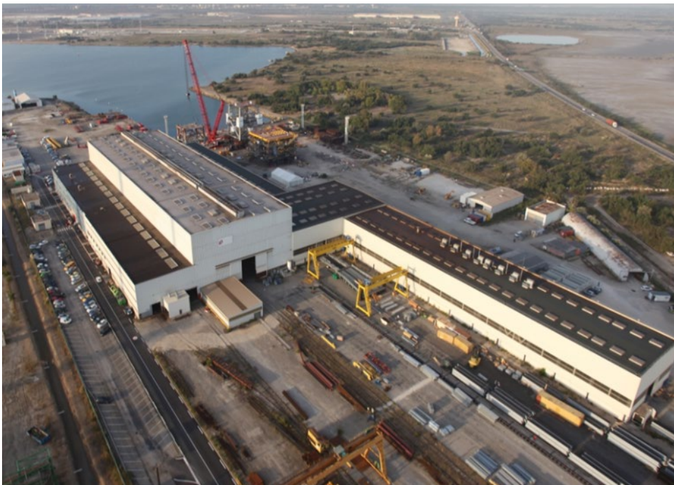
Photographie 5 : Vue aérienne du site d'EIFFAGE METAL à Fos-sur-Mer (Source : EIFFAGE)
