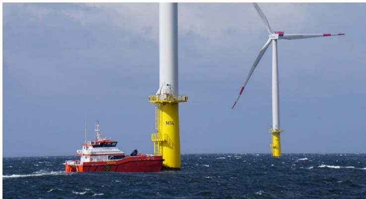
Photographie 7 : Exemple de CTV approchant d'une fondation offshore (Source : Njord Offshore)
