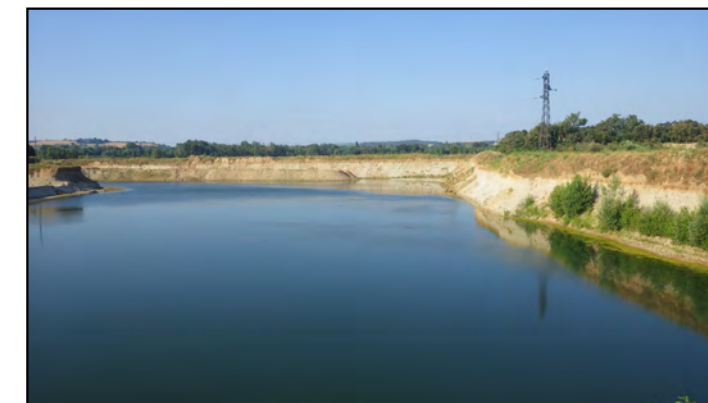
Photo E : Bassin du secteur Sud-Ouest du périmètre autorisé
