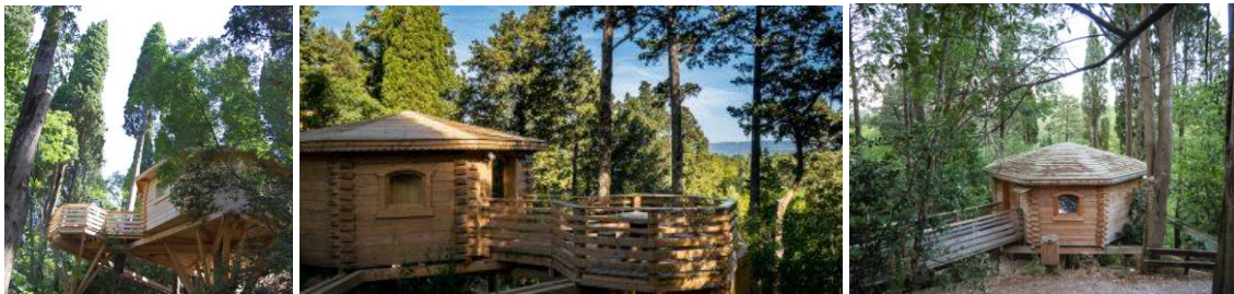
Vues des cabanes existantes sur la commune de Villalier
