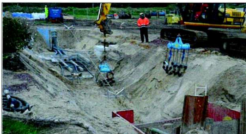
Figure 25 : Tirage au niveau de la chambre d'atterrage
