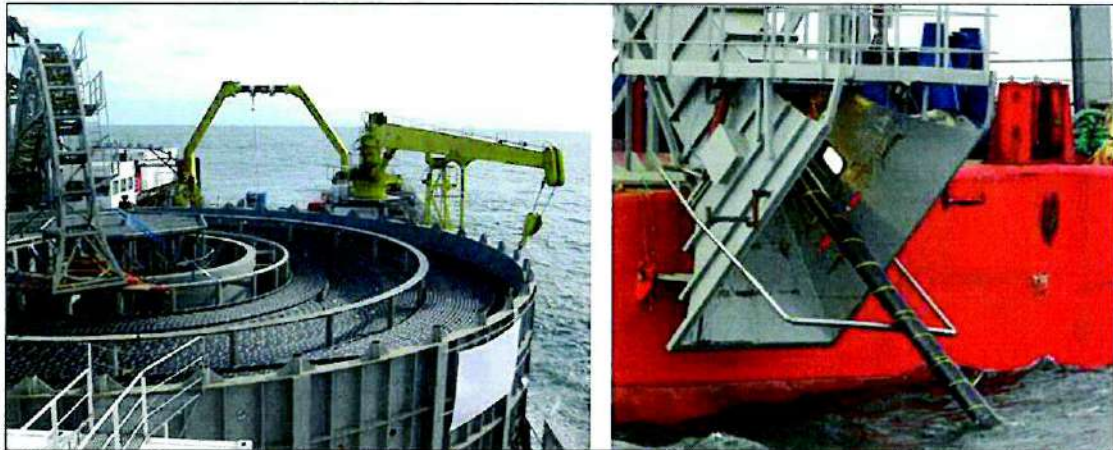
Figure 11 : Pose des câbles sous-marins
