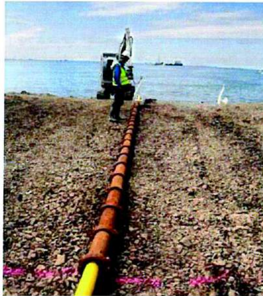
Figure 18 : Coquilles en fonte articulées
