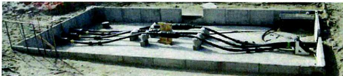
Figure 24 : Chambre de jonction d'atterrage en travaux
