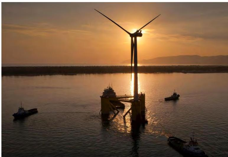
*Photographie 6 : Remorquage du prototype WindFloat 1 (Source : PPI)*
