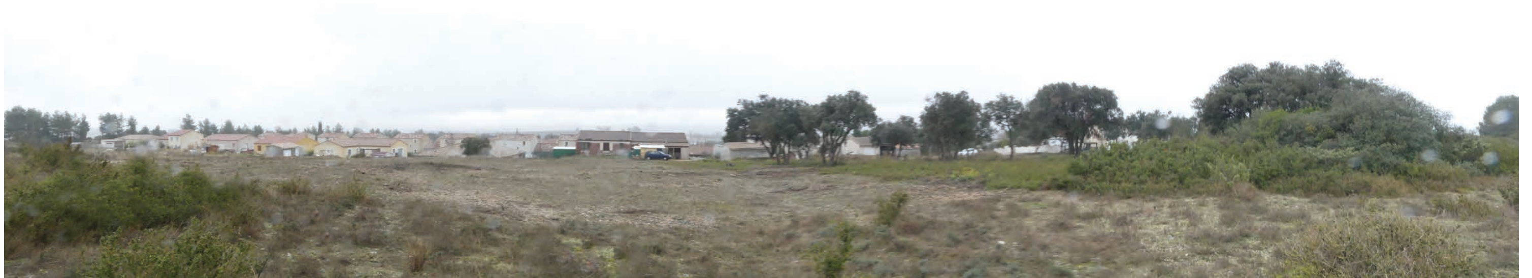
VUE 6 - Vue depuis le merlon Sud sur le secteur urbanisé présent au Sud à une centaine de mètres du site. Cette frange non bâtie entre les habitations et le site n'est pas véritablement valorisée et apparaît davantage comme un délaissé.
