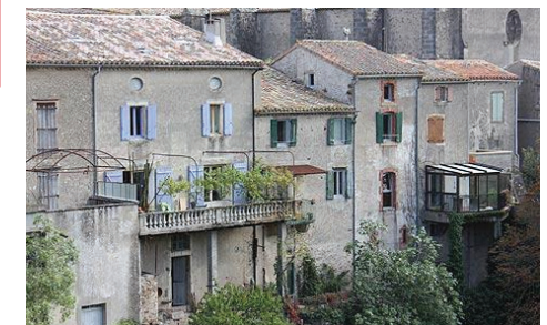
Bâti traditionnel dense avec maisons de villages accolées - Montolieu
