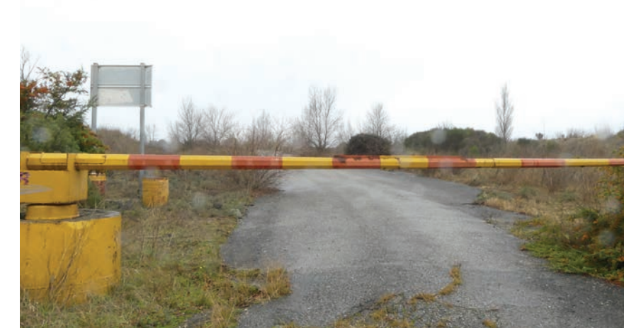
VUE 3 - Accès au site et voie en enrobée.
