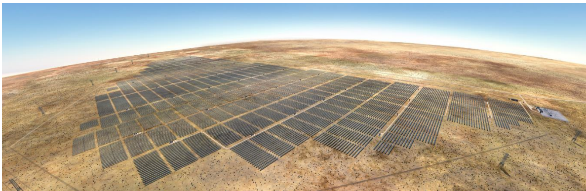
Photographie II-4 : Centrale de Prieska – Afrique du Sud (Source : Total Solar)
