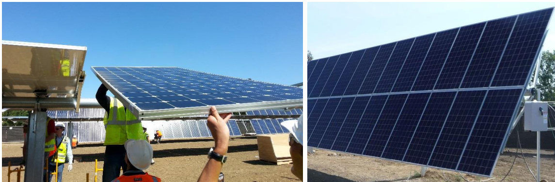
Photographie II-6 : Mise en place des panneaux photovoltaïques – Source : Total Solar
