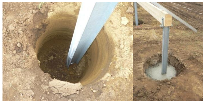
Photographie II-10 : Réalisation de fondations béton superficielles pour ancrage des structures (Source : Total Solar)
