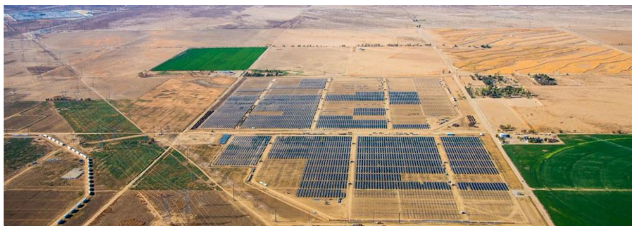
Photographie II-5 : Centrale de Sunpower – Californie, USA (Source : Total Solar)
