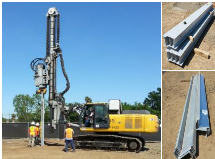
Photographie II-11 : Mise en place de pieux battus au sol pour ancrage des structures (Source : Total Solar)
