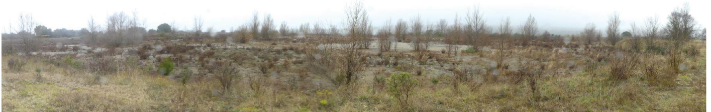
Photographie III-11 : Photo du site depuis le merlon sud (Source : 2Br)
