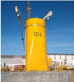
Le mât contient des structures secondaires internes (plate-forme, échelles, monte-charge), des équipements électriques (câbles, transformateur, cellules, convertisseur) et des équipements de sécurité (éclairage, extincteurs). Les sections de tour sont assemblées au moyen de brides boulonnées.
