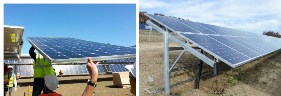
FIGURE 7 : MISE EN PLACE DES PANNEAUX PHOTOVOLTAÏQUES – SOURCE : TOTAL SOLAR
