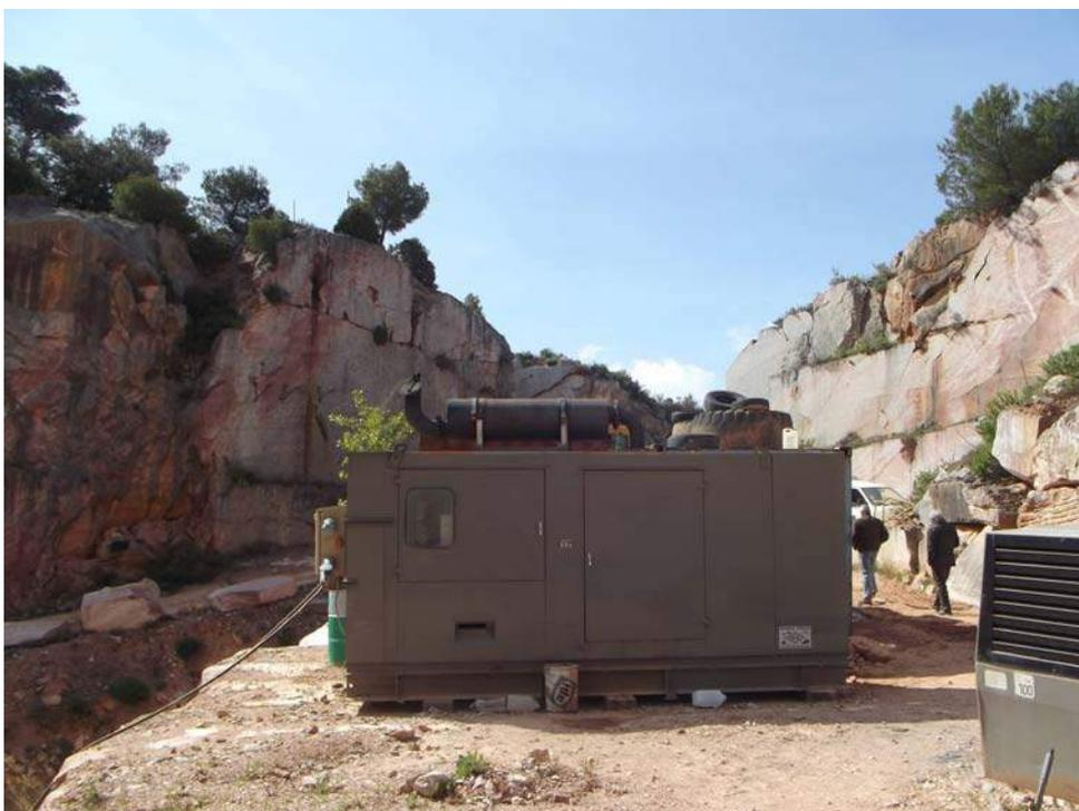
Groupe électrogène implanté au droit de la plate-forme technique 318 m NGF. Il assure l'alimentation de l'ensemble des outils de sciage et de découpe du marbre.
