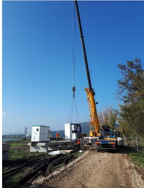
**FIGURES 2 ET 3 : RÉALISATION D'UNE TRANCHÉE ET GRUTAGE DES POSTES**
