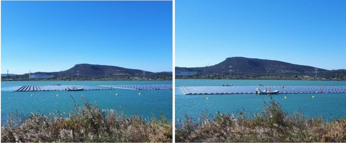
**FIGURES 6 ET 7 : MISE À L'EAU ET INSTALLATION D'UN ÎLOT SUR LE LAC**
