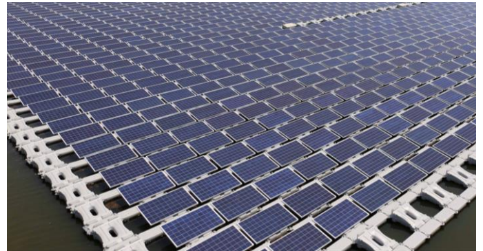
Assemblage de flotteurs avec panneaux solaires
