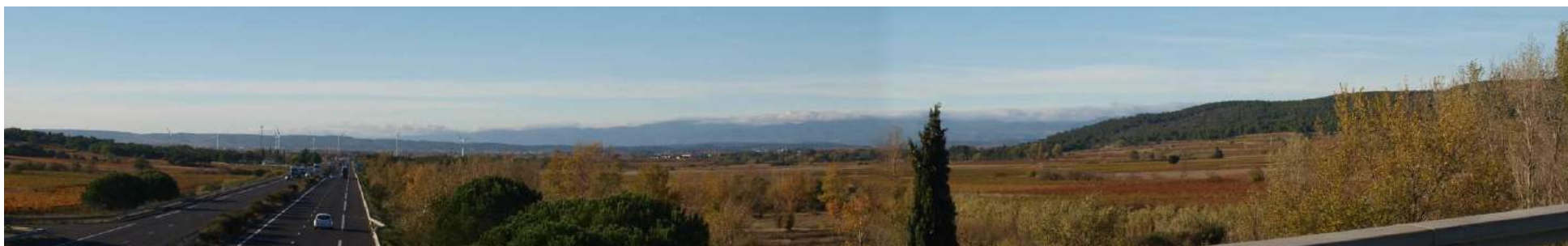
Au niveau du passage de l'Autoroute A 61, au Sud de Bizanet.
