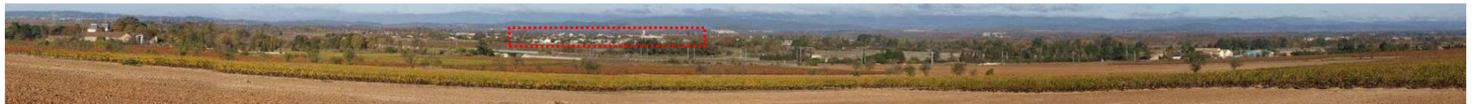
3- Toujours depuis la RD 24, dont la situation légèrement en hauteur permet des visions lointaines sur la plaine. Les visions du projet s'établissent sur de longues distances intégrées aux composantes lointaines.
