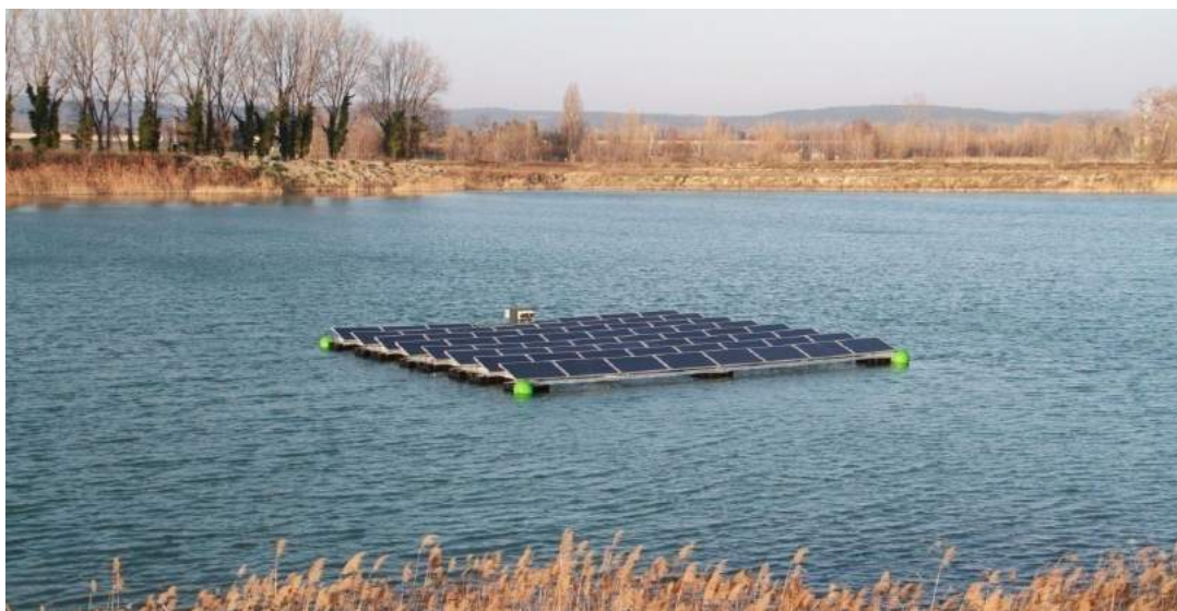
Illustration N° 4 : Photographie du prototype de structure photovoltaïque flottante, mis en place à Piolenc (Vaucluse) en février 2011
