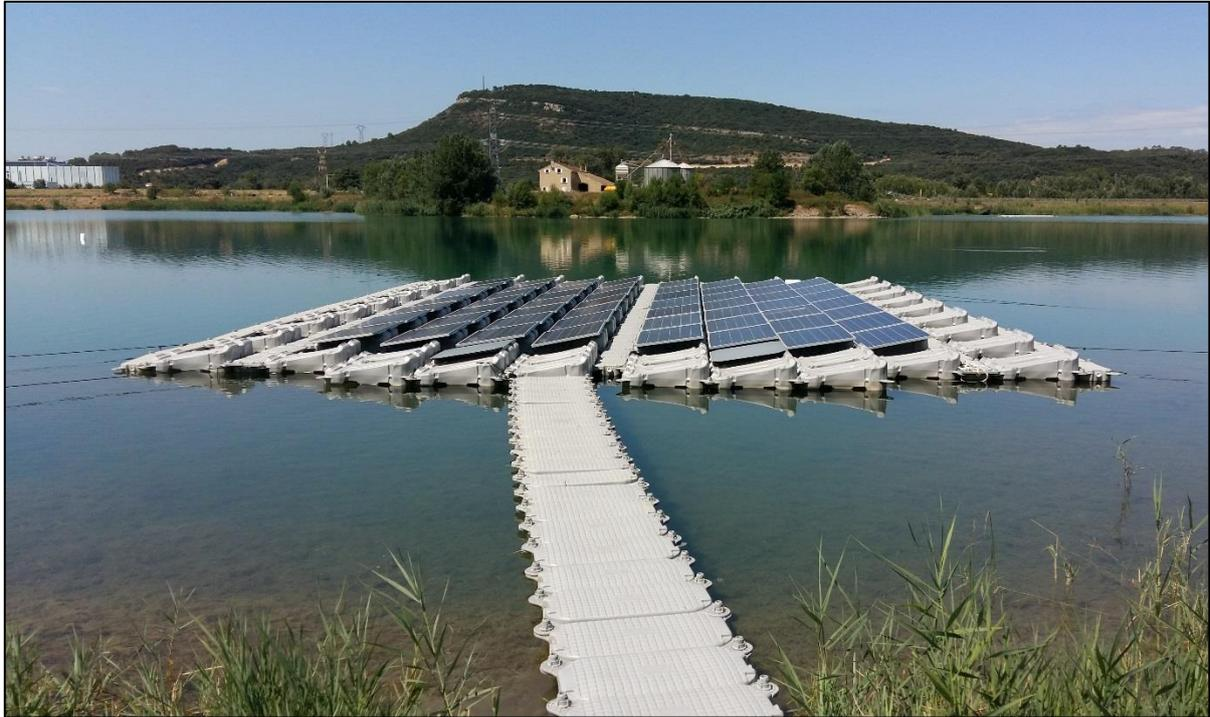
*Prototype de centrale flottante installé à Piolenc*
