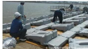
Exemple d'assemblage sur plateforme de lancement
