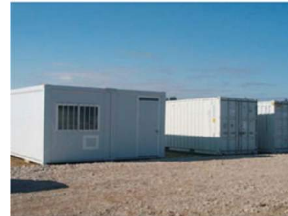
Figure 21 : Installation de la base-vie Source : EDF Energies Nouvelles
