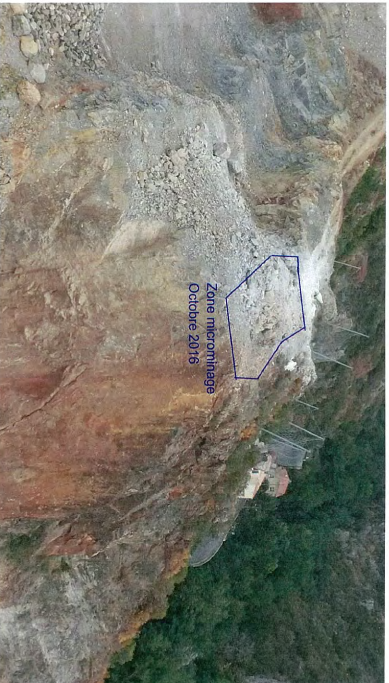
Vue de front de taille après tirs de microminage – Octobre 2016
