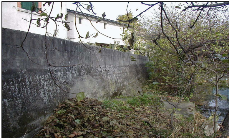
Ce sont de nouveaux locataires qui occupent les lieux, l'ancien propriétaire étant décédé. Le mur de soutènement qui borde la rive gauche de l'Aude est récent.
