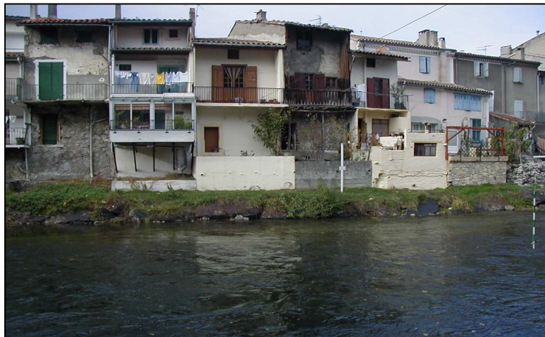
La berge gauche est entièrement occupée par des murs de soutènement construits par des particuliers, en prolongement de leurs habitations. Photographie du site présumé.
