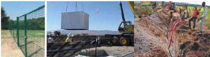
Illustration 23 : Exemple de chantier d'un parc photovoltaïque
