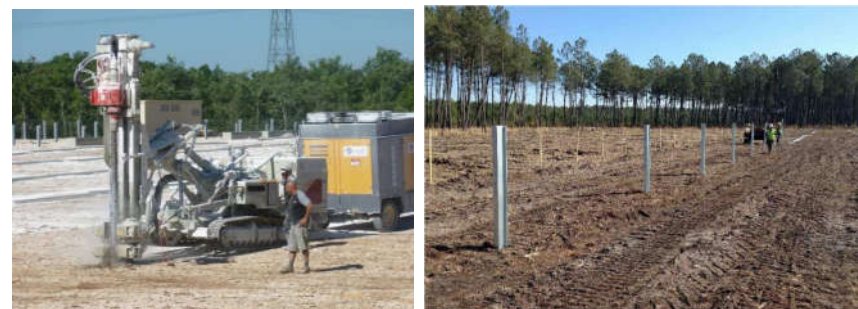
Illustration 13 : ancrage au sol par pieux battus
