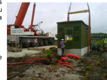
Exemple d'acheminement d'un poste de livraison préfabriqué
