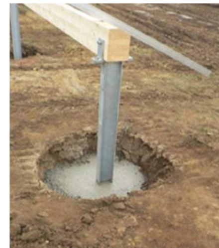
Figure 22 : Fondation béton (à gauche) ; fondation vis (à droite)
