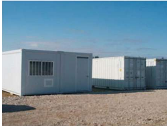
Figure 20 : Installation de la base-vie Source : EDF Energies Nouvelles
