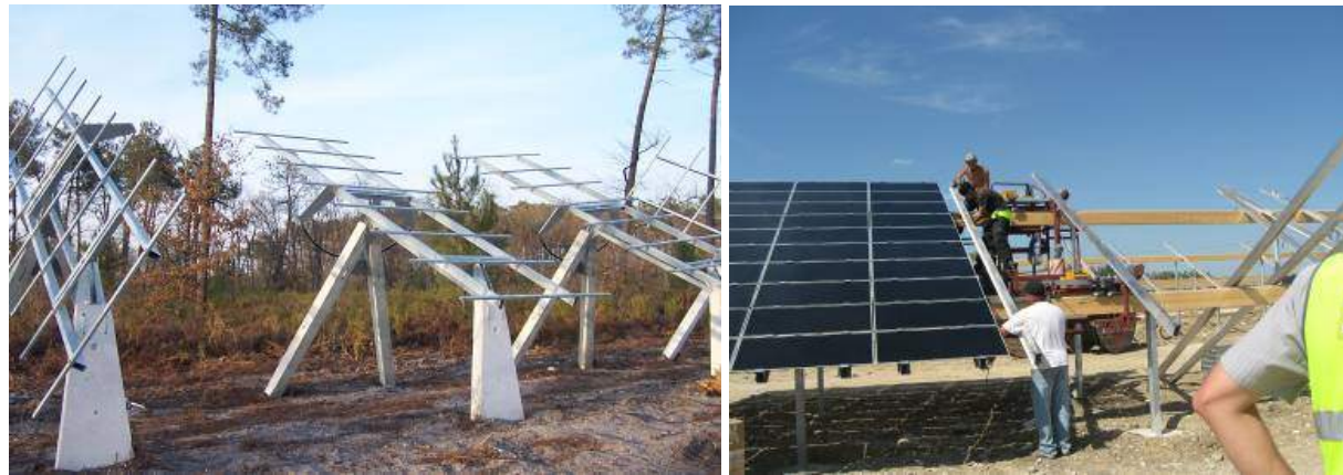
Figure 23 : Montage du support (à gauche), montage module (à droite) Source : EDF Energies Nouvelles
