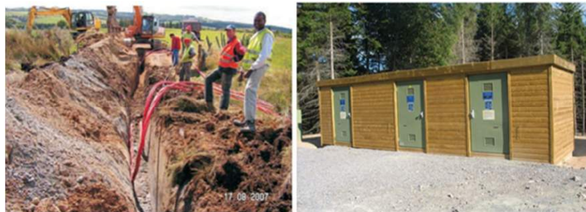
Figure 24 : Déroulage et pose des câbles (à gauche), poste de livraison (à droite) Source : EDF Energies Nouvelles
