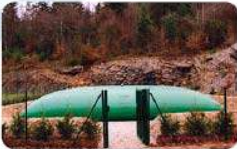
Citerne de 140 m 3 pour la défense incendie d'une centrale
