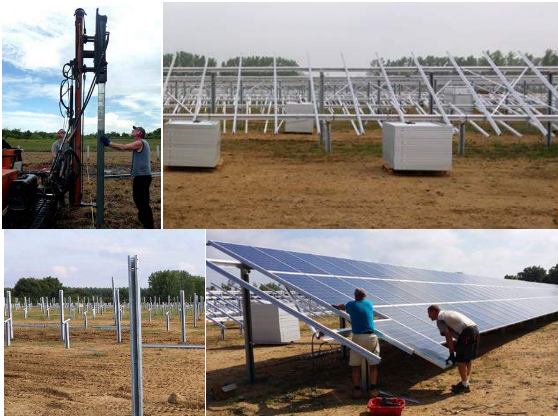
Fondations et ancrages (Source : LANGA SOLUTION)
