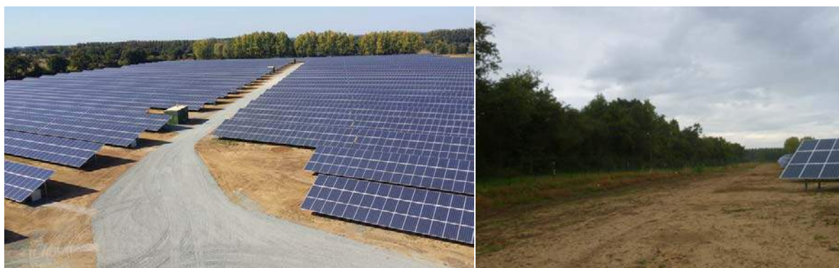
Voie principale et voirie périphérique (Source : LANGA SOLUTION projet Fillé)
