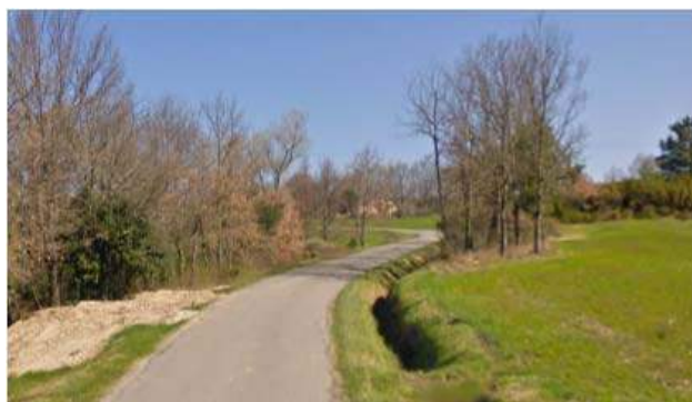
La RD34, au Sud de Villemagne
