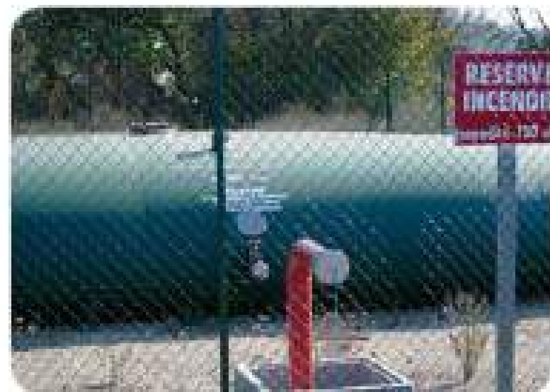
Citerne de 130m 3 encaissée au centre
