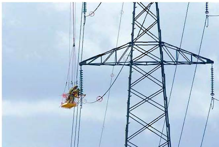
Figure 64 : Opérateurs RTE en train d'installer des balises sur les lignes électriques
