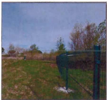
Clôture rigide isolant la station de reproduction de la Diane du chantier de rocade
