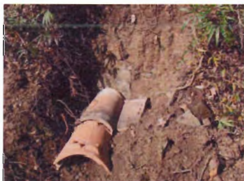
Tuiles déposées dans le surcreusement (de préférence à au moins 40 ou 60 cm de profondeur), constituant un abri hors gel
