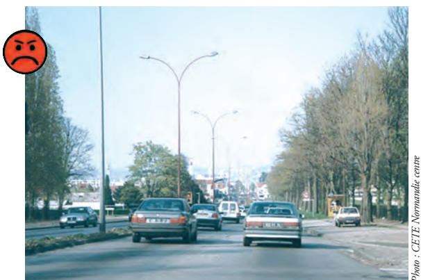
Exemple d'infrastructure large et rectiligne incitant à la pratique de vitesses élevées et favorisant les dépassements.
