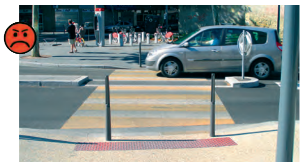
L'utilisation de peinture colorée au niveau des passages piétons est à éviter en raison des problèmes de glissance et des diminutions de contrastes.
