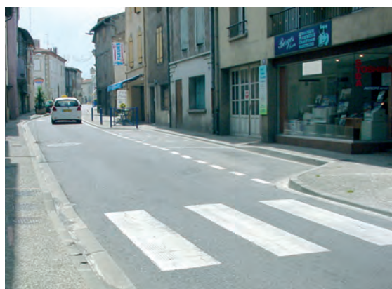
Une avancée de trottoir a été créée, elle permet de gérer la distance entre le stationnement et le passage piéton, améliorant les visibilités réciproques des usagers. La distance à parcourir sur la chaussée lors de la traversée piétonne est, de plus, réduite.
