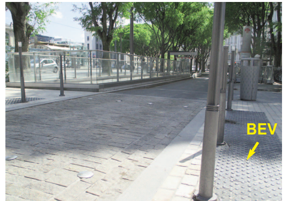
Traversée suggérée par changement de matériaux équipée de BEV, mais sans marquage de passages pour piétons
