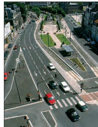
Exemple de voie principale
