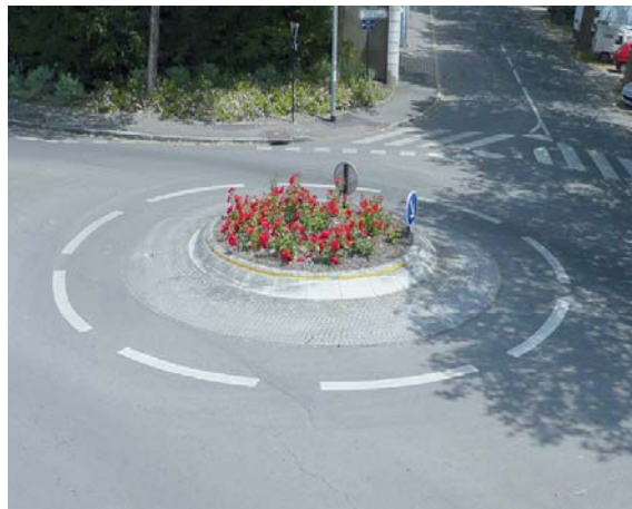
Source : CETE de l'Est
