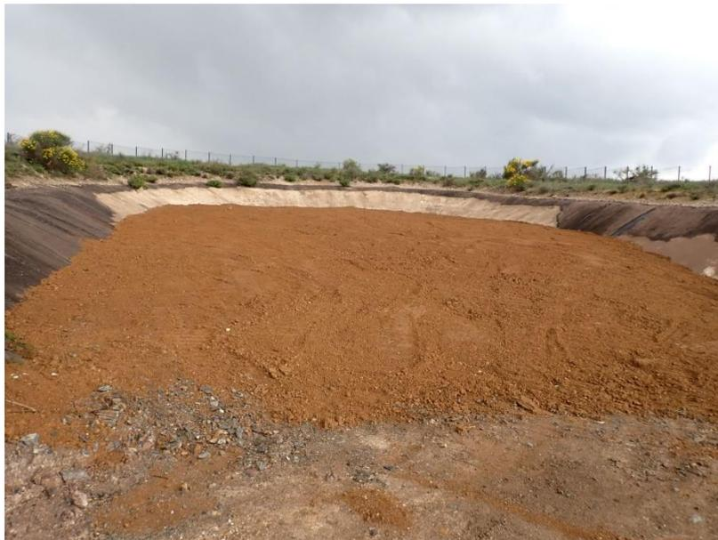
*Alvéole provisoirement protégée par une couche de terre (photo DPSM)*
