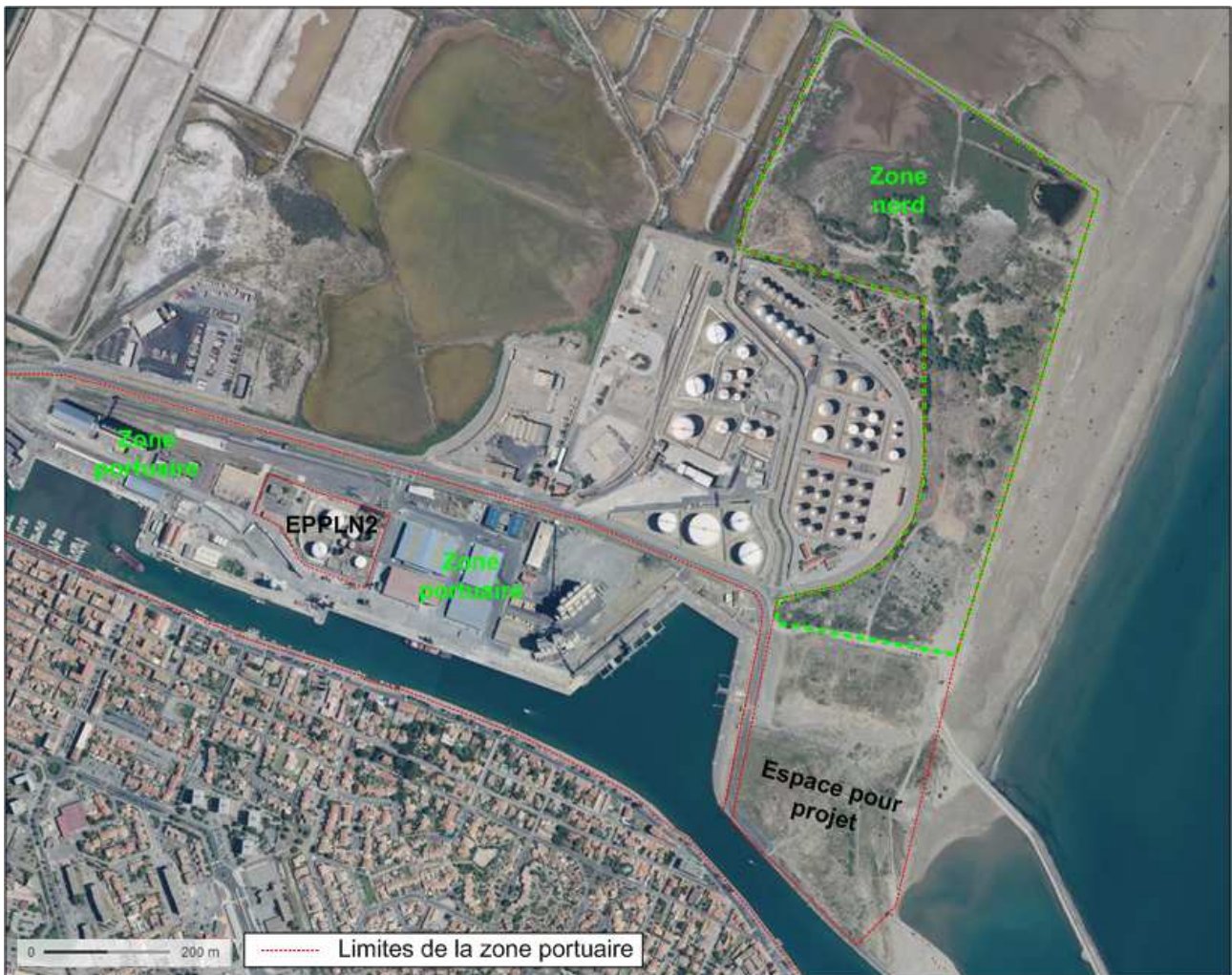
Figure 4: Localisation des aires de transit (vue aérienne de la zone d'implantation)
