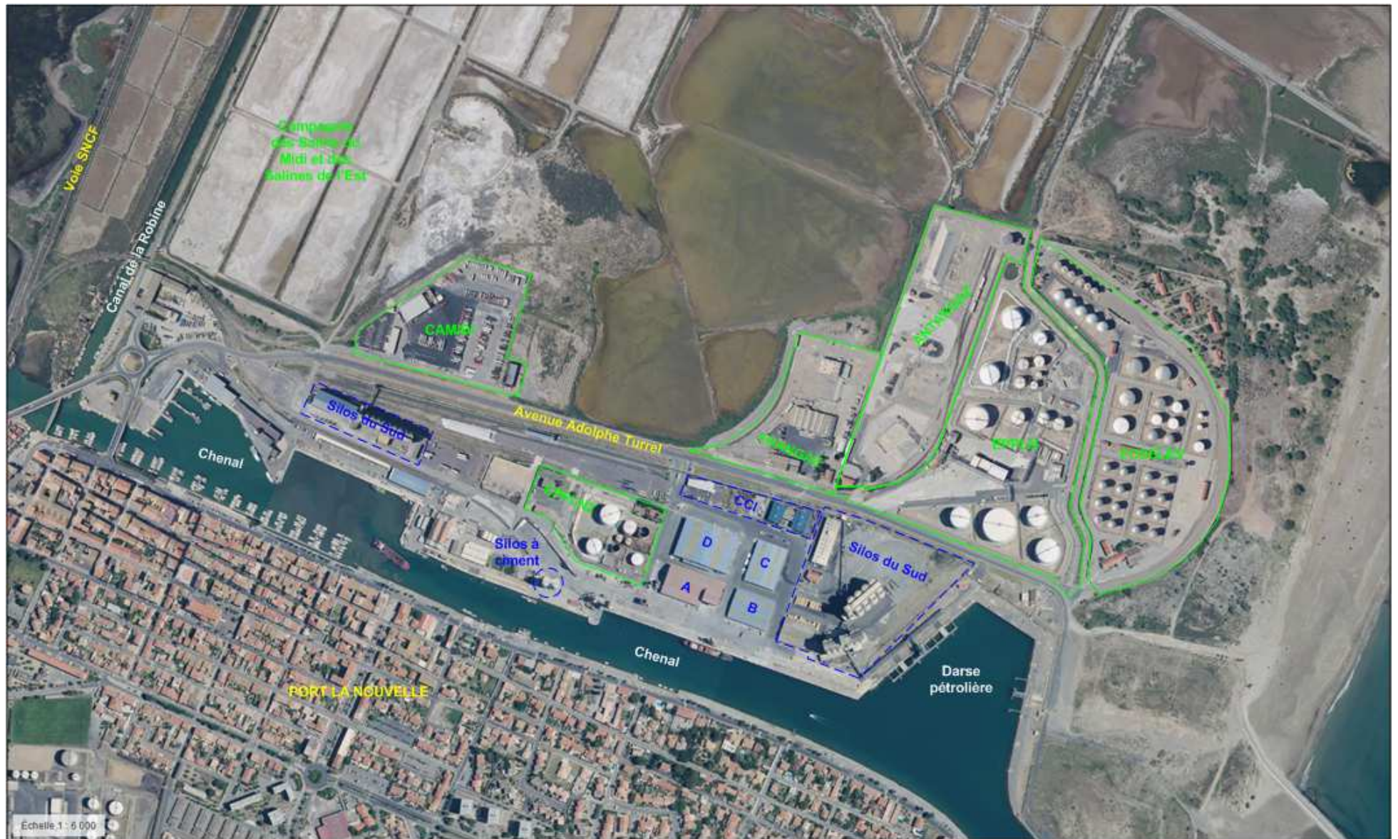
Figure 5 : Vue aérienne du site et de son environnement immédiat
